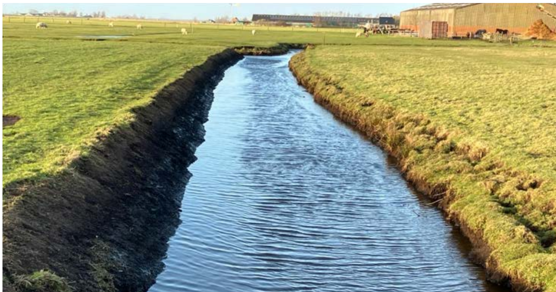
Figuur 7.1.1: De linker oever is recent aangelegd met een talud van ca 1:1, de rechter oever is ca 10 jaar geleden aangelegd en heeft inmiddels een loodrechte oever. Hierdoor ontstaat een bakprofiel van de sloot (zie figuur 7.1.2, rechts; Veenweidesloot van de toekomst/ Debby van Rotterdam januari 2024) [4].
