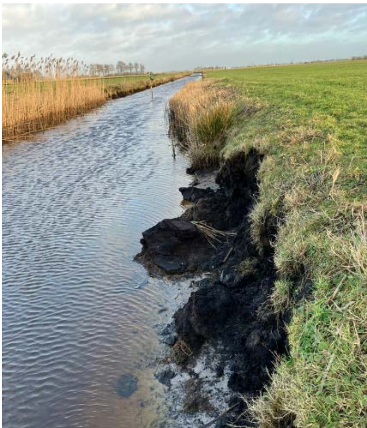
Figuur 7.1.7: Waar riet zich handhaaft treedt minder instabiliteit op, waar het niet aanslaat treedt het vaker op. De aanwezigheid van zand (drijfzand, zie foto vooraan) nabij het slootwateroppervlak vergroot het gevaar op instabiliteit.
